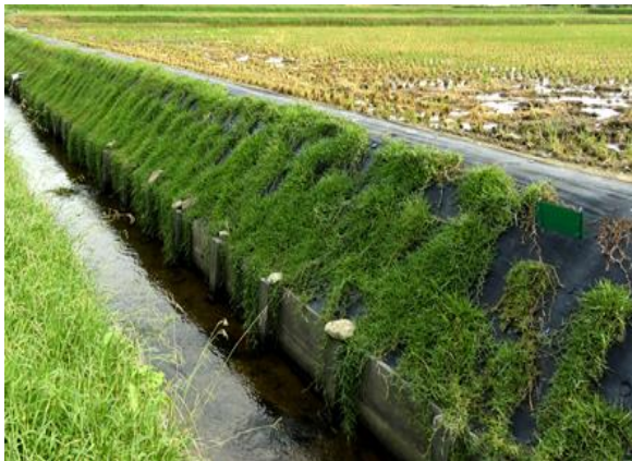
河岸湖畔の施工例(滋賀県)
