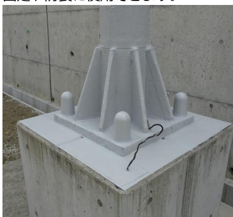
ウレタン注入材を充填 更にNEac工法を施工 複雑な形にもNEac工法で成型可能
