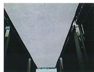
室外機下からの写真
