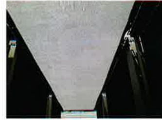
室外機下からの写真
