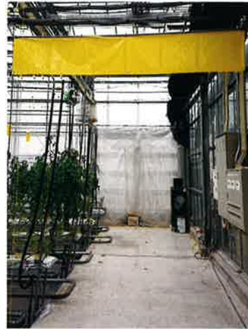
栽培室の仕切部
