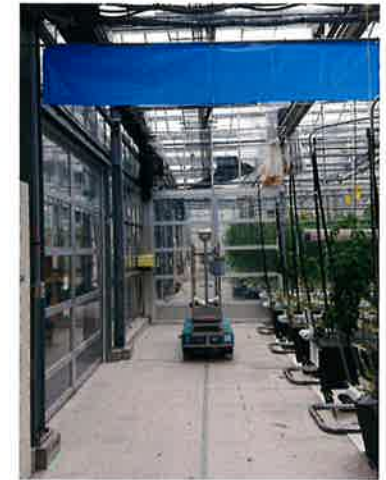
栽培室の仕切部
